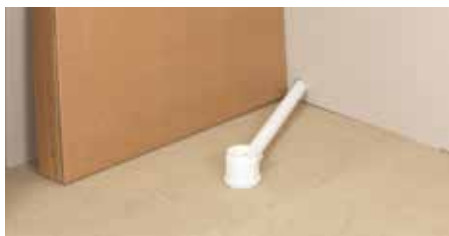
1. Complete plumbing work area. 1. Procédez aux travaux de plomberie.
